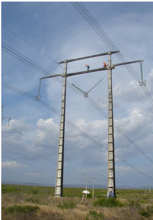
Figura 1 – Estrutura de Concreto da LT
