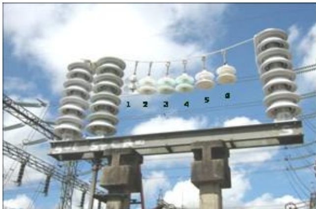
(a) Montagem na SE de Utinga
