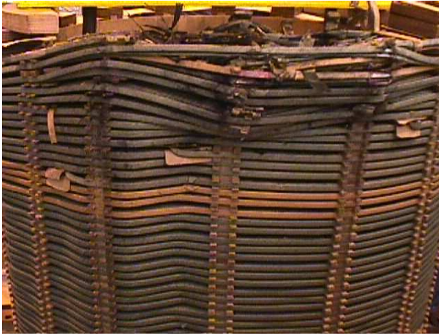
Figura 6: Deformação no enrolamento de BT
