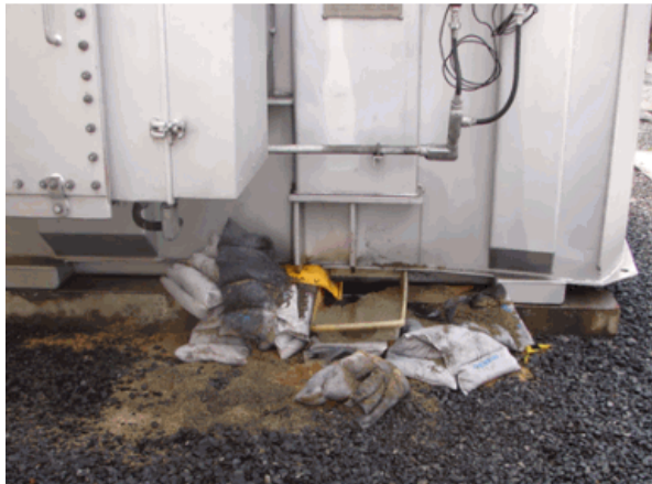
Figura 4: Derramamento de óleo e deformação inferior do tanque
