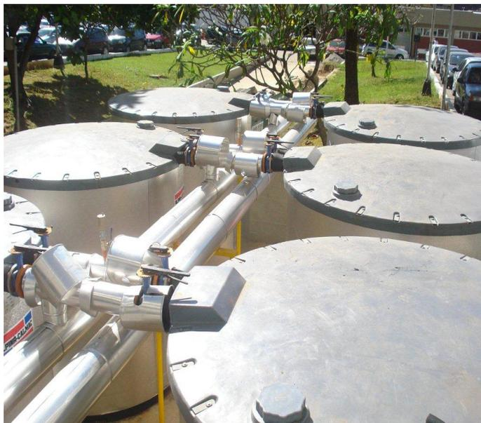
Figura 3 - Tanques de gelo - Sistema de Termo-Acumulação no HNMD
