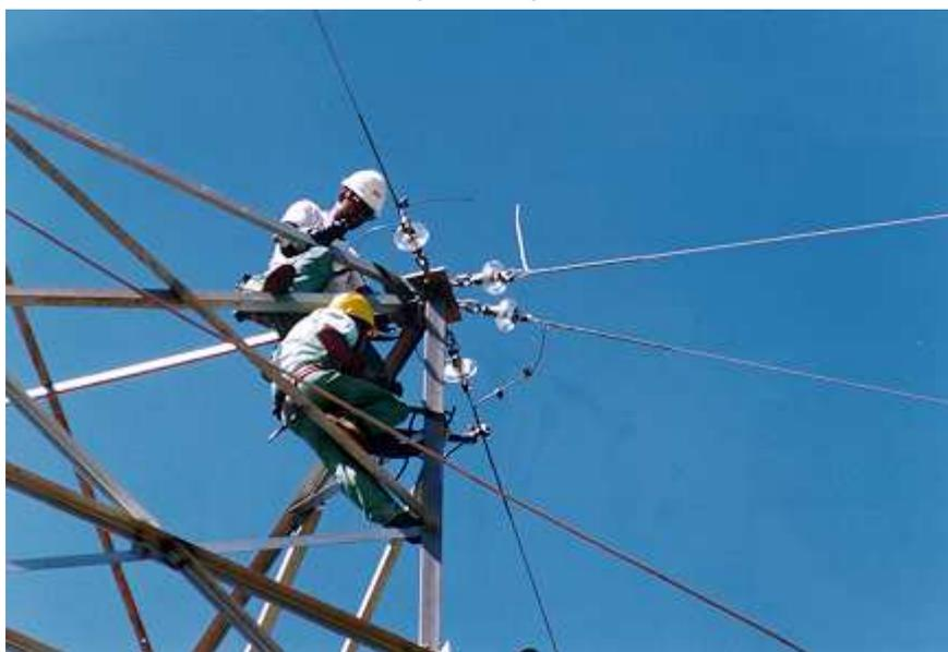
Figura 3 – Desconexão de LT
