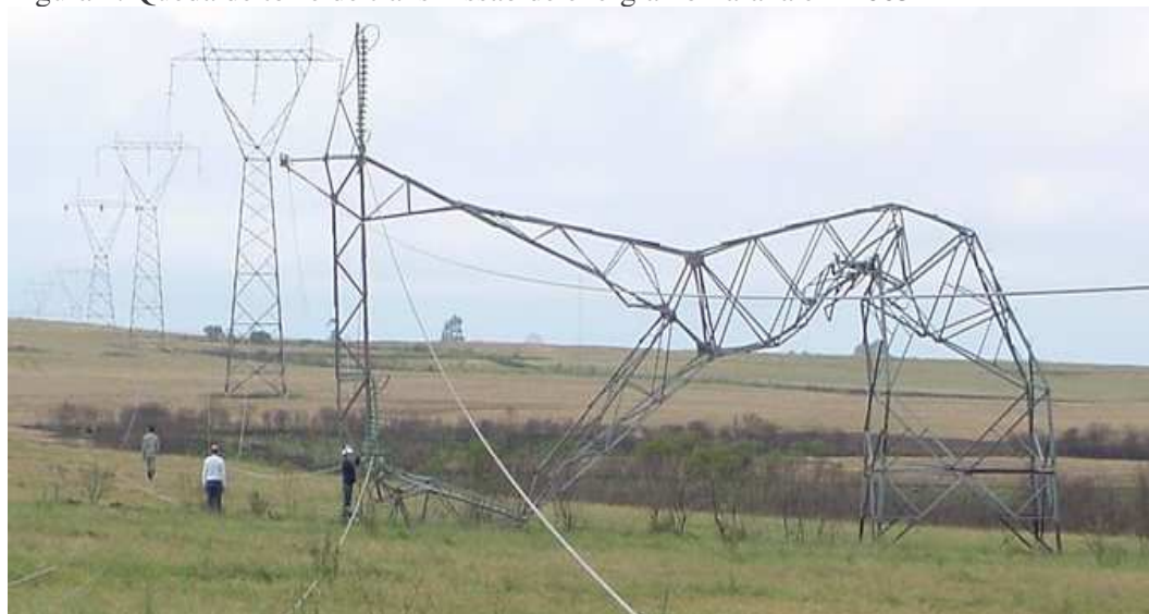
Figura 1: Queda de torre de transmissão de energia no Paraná em 2003
