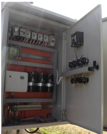
Figura 4. Painel de comando da Chave a vácuo.
