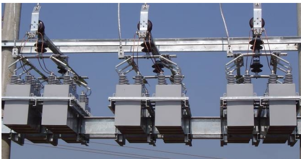
Figura 2 - Conjunto de capacitores definido como CSMU
