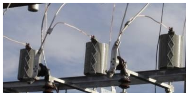
Figura 10 - Reator de núcleo de ar para proteção do CSM.
