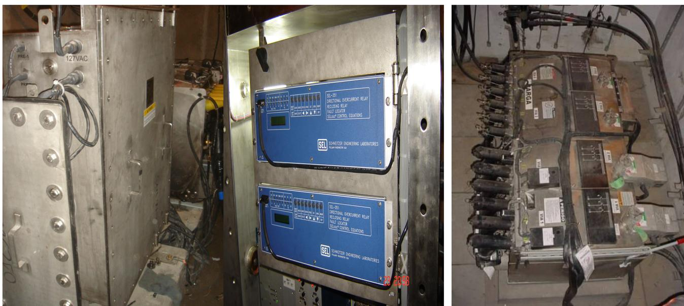
**Figura 4 – Painel Submersível Desenvolvido Para os Equipamentos de Supervisão, Controle e Proteção e a Chave Disjuntora.**
