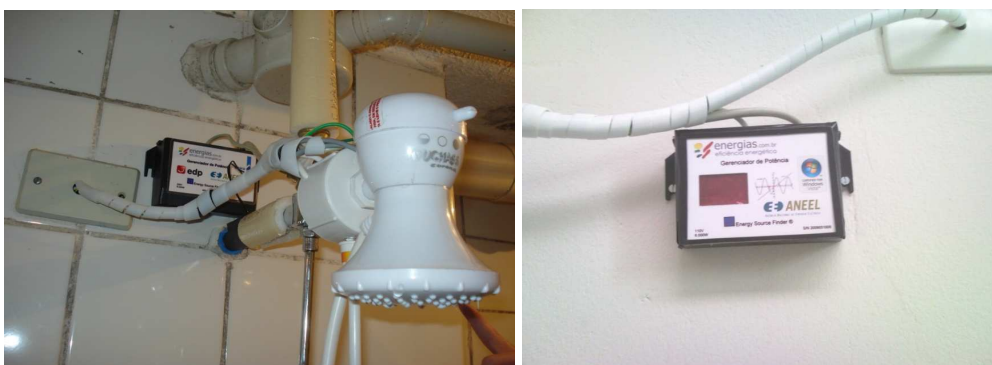
Figura 2: Dispositivo controlador instalado no chuveiro elétrico
