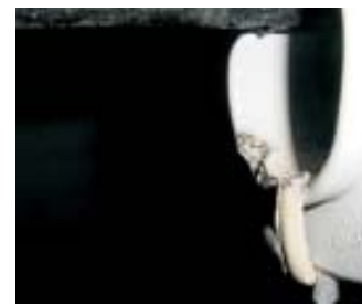
FIGURA 11 - Danos no espaçador 2 após ensaio de compatibilidade dielétrica com cabo 1.
