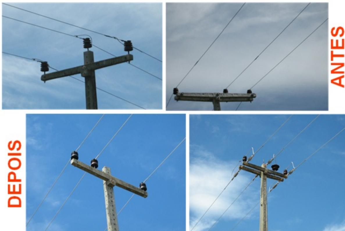
Figura 3 - Rede reformada com a utilização dos condutores reutilizados.
