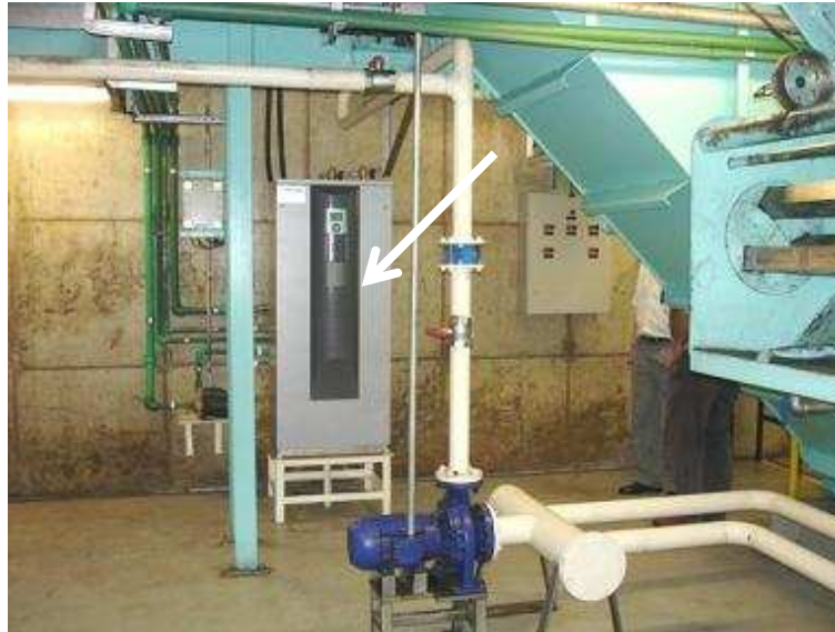
FIGURA 7 – No segundo plano, a bomba de calor instalada
