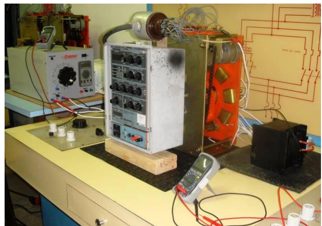
Figura 13. Vista lateral direita da bancada, onde é possível observar o Autotransformador, o Regulador de Tensão e o Varivolt.
