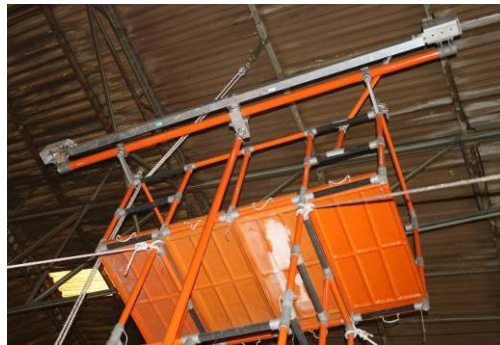
Figura 5 – Chave seccionadora montada no andaime
