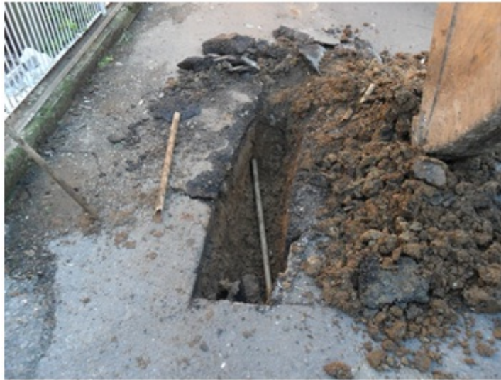
Figura 6 - Conserto de vazamentos.
