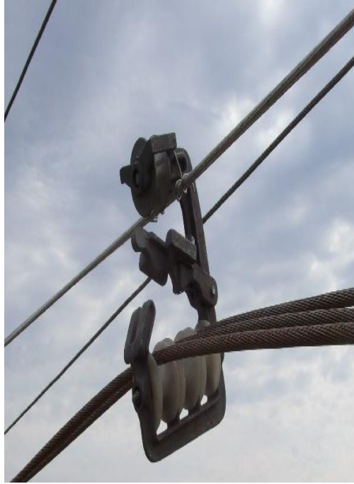
Figura 2: Carretilha para Lançamento de Condutores
