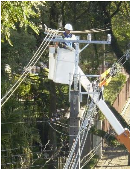
Figura 7: Retirada dos Condutores
