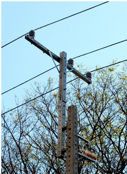
Figura 4: Elevação da Estrutura N1
