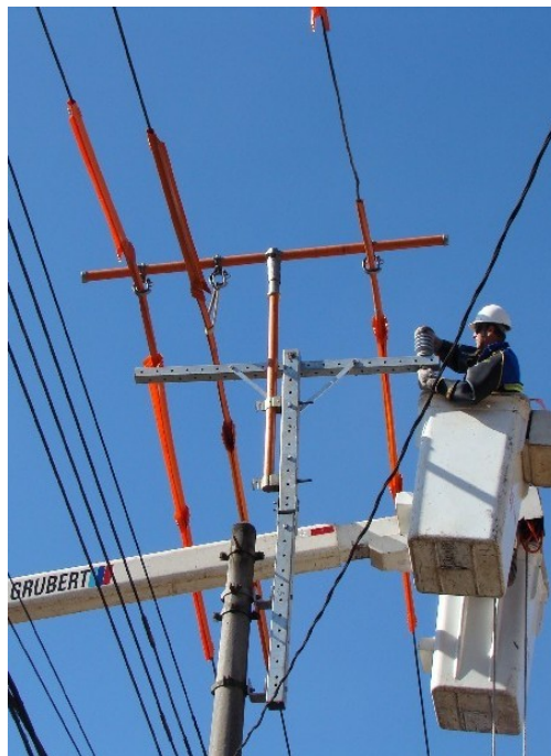
Figura 1: Mastro Tubular Articulado e Cruzeta Provisória
