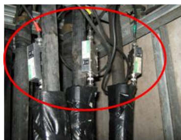
Fotos 7 e 8 : Sensores instalados em condutores de média tensão
