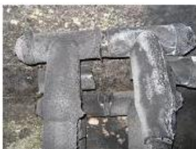
Fotos 9 e 10 : Terminais e conexões de cabos subterrâneos com falhas estruturais de isolamento
