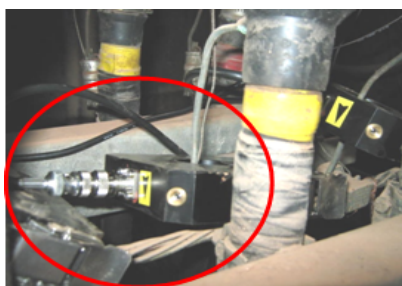
Fotos 7 e 8 : Sensores instalados em condutores de média tensão
