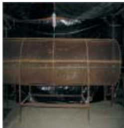
FIGURA 5 – Condutor no Centro da Gaiola - Cabana
