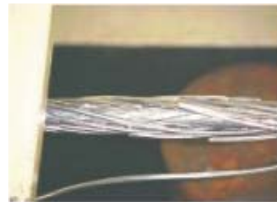
FIGURA 3- Rompimento do Cabo
