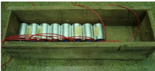
Figura 13 – Conjunto de capacitores utilizados para a compensação reativa, com tensão nominal 380VCA.
