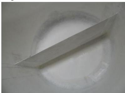
Figura 9. Divisória localizada no fundo do biodigestor para garantir o tempo de retenção
