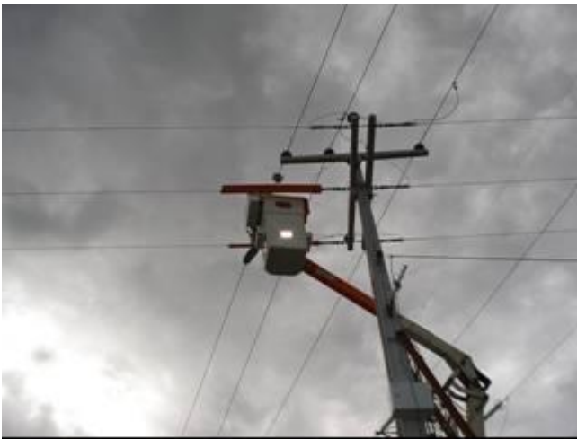
Figura 10. Instalação de sensores nas linhas
