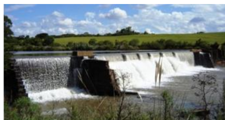
Figura 1. Barragem e reservatório da PCH.
