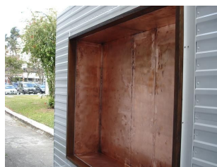
Figura 17. Vista externa da cavidade principal já instalada no trailer
