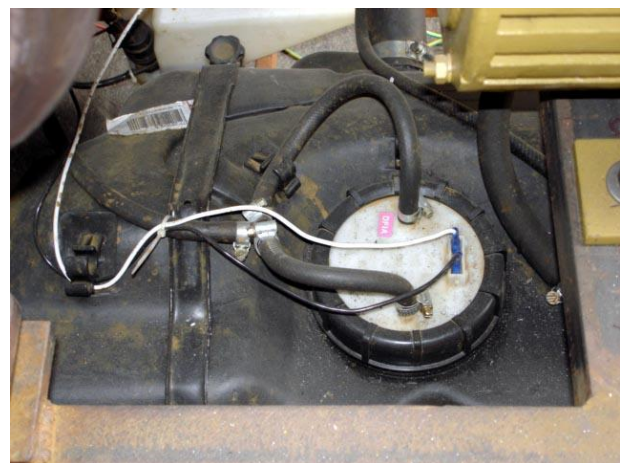
Figura 7. Tanque de combustível.
