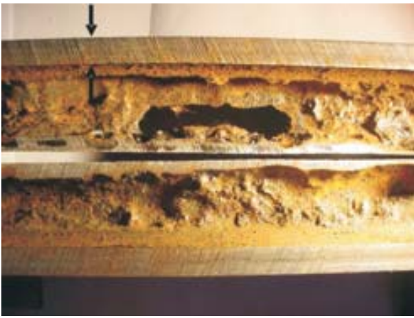
FIGURA 2. Aspecto interno do furo, após seccionado o tubo. Observa-se a intensa redução de espessura de parede junto à aleta e no lado do fogo. No lado do isolamento praticamente não há redução de espessura (seta).
