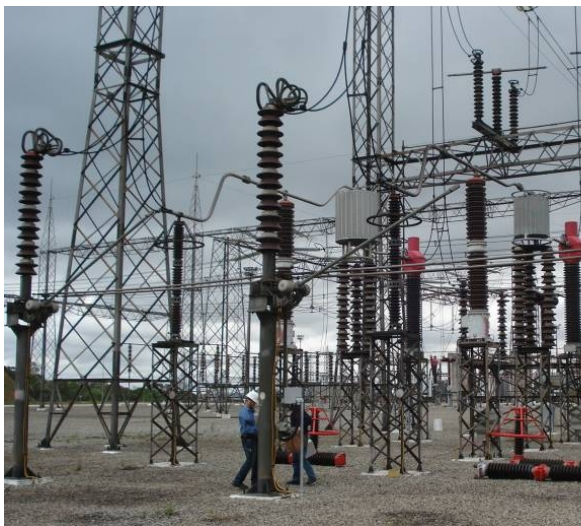
Figura 8. Vista, em segundo plano, dos três pára-raios de ZnO da LTA MO-NOD.
