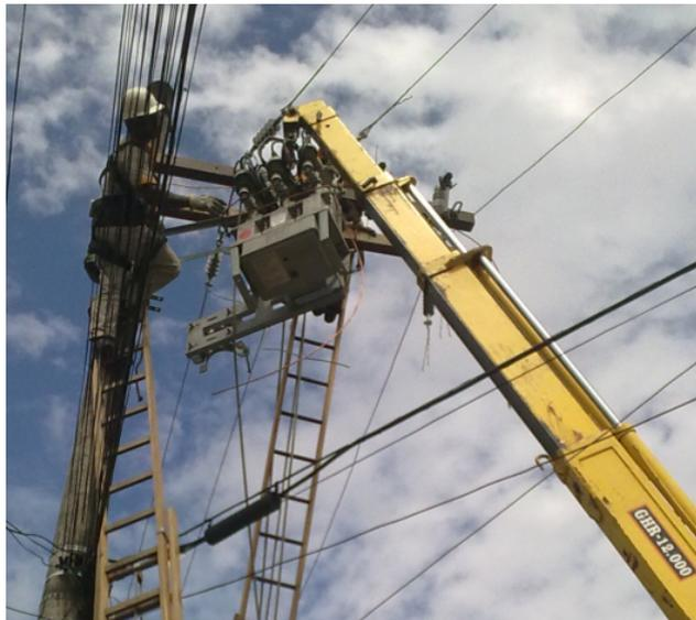
**Figura 1 - Instalação de sistema convencional de medição exteriorizada em linhas de média tensão**
