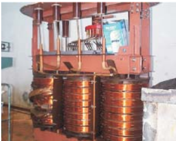
FIGURA 1 – Transformador com a fase C queimada por sobrecarga
