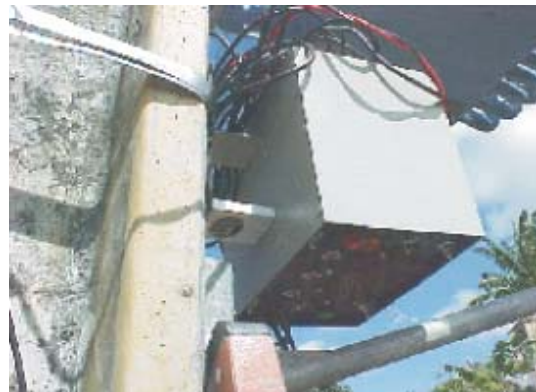
FIGURA 9 – Protótipo já instalado e em funcionamento em Salvador
