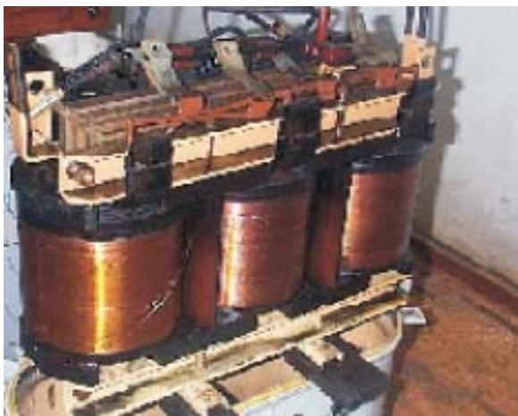
FIGURA 2 – Transformador com a fase C queimada por sobrecarga
