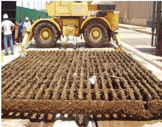
Figura 1 – Bioincrustação na grade de tomada d'água
