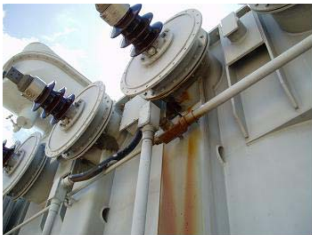
FIGURAS 3 e 4 – Vazamento pelo caneco da bucha e pela tampa.
