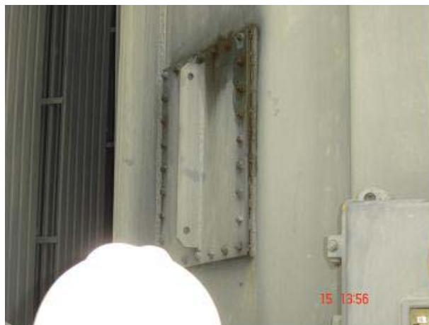
FIGURAS 1 e 2 – Vazamento em válvula de radiador e em janela de inspeção vertical.
