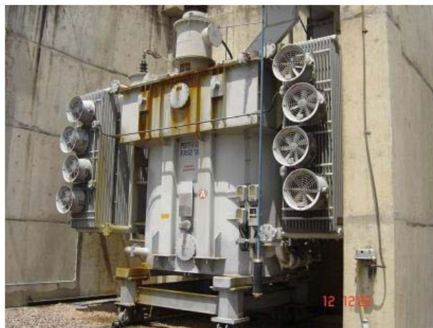
FIGURAS 3 e 4 – Vazamento pelo caneco da bucha e pela tampa.
