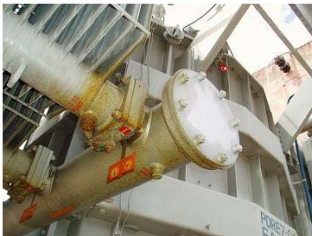
FIGURAS 1 e 2 – Vazamento em válvula de radiador e em janela de inspeção vertical.
