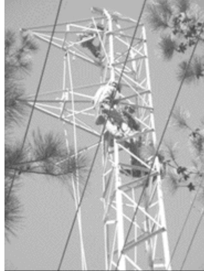
FIGURA 3 – MONTAGEM DA ESTRUTURA
