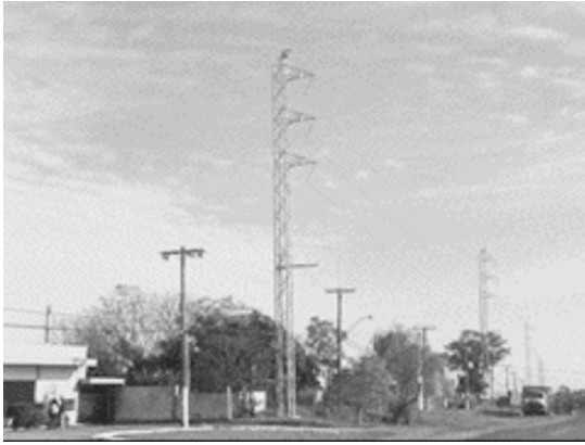
FIGURA 2 – VISTA GERAL DA LT
