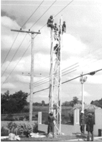
FIGURA 5 – MONTAGEM DA ESTRUTURA
