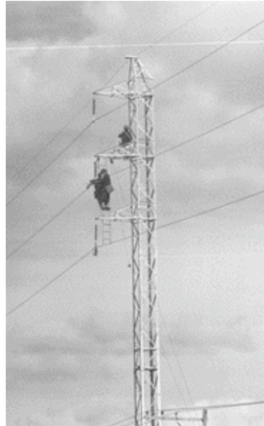
FIGURA 7 – MONTAGEM OS ISOLADORES
