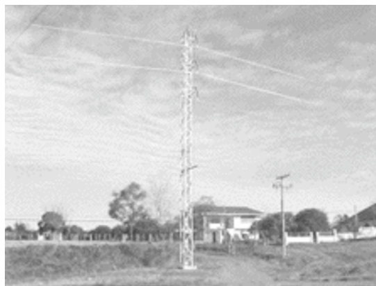
FIGURA 1 – ESTRUTURA DE SUSPENSÃO
