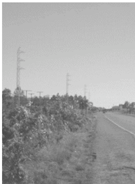
FIGURA 12 – VISTA GERAL DA LT
