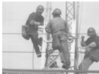
FIGURA 4 – MONTAGEM DA ESTRUTURA
