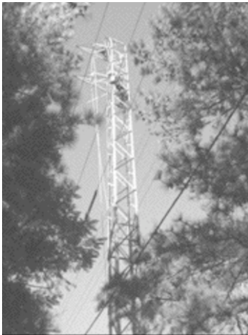
FIGURA 6 – MONTAGEM DA ESTRUTURA
