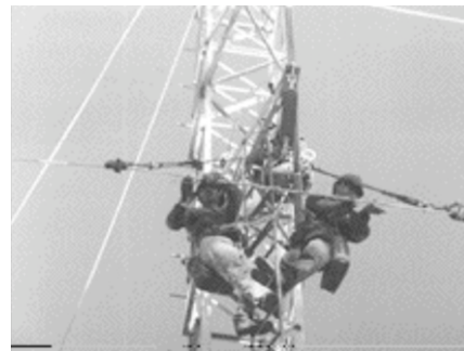
FIGURA 8 – MONTAGEM DOS ISOLADORES
