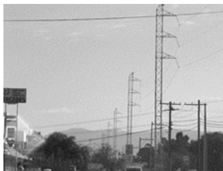
FIGURA 11 – VISTA GERAL DA LT
