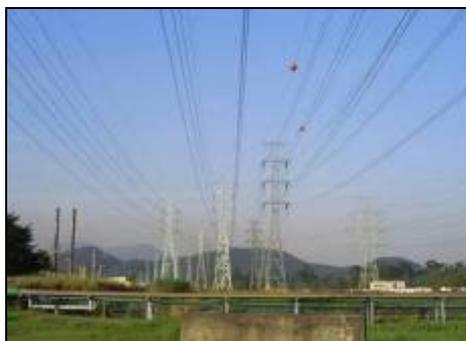
FIGURA 5 - Faixa dos 6 Circuitos de 88 kV entre Baixada Santista e Henry Borden e da Linha em 230 kV
