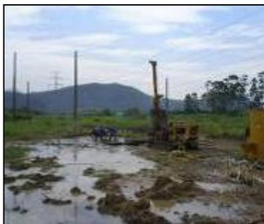
FIGURA 7 - Perfuração das Estacas Raiz e Preparação dos Blocos de Concreto.
