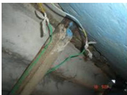
Figura 01: Situação em que a isolação é feita com sacola plástica, colocando a moradia em risco de incêndio devido material ser inflamável.
