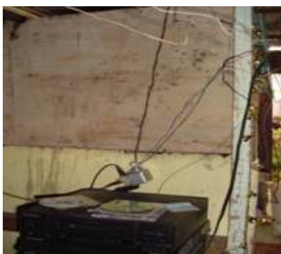
Figura 02: Situação em que mais de um equipamento está ligado na mesma tomada, que por sua vez está em condição insegura tanto para desligar equipamentos como com sobrecarga.
