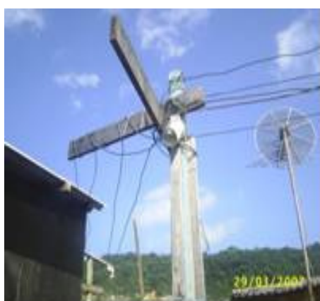
Figura 06: Na adequação da rede de distribuição e iluminação das vielas e becos foram instalados postes que, para serem levados aos pontos de engastamento, tiveram que ser seccionados e posteriormente “emendados”. Também foi necessária a redução do braço de iluminação para possibilitar a iluminação da passagem.
