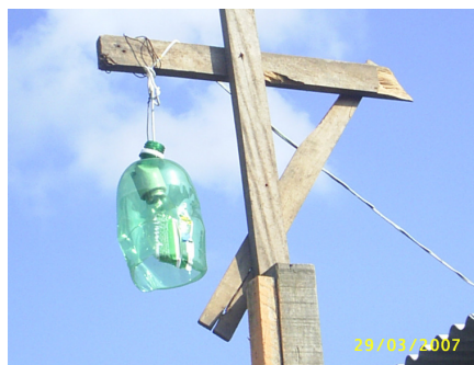
Figura 05: a) Poste contendo ramal clandestino que energizava uma das comunidades atendidas. b) Sistema de iluminação improvisado pelos moradores nas vielas e becos.
