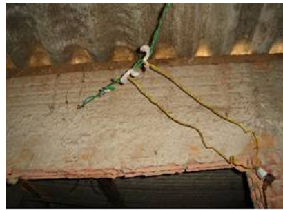
Figura 01: Situação em que a isolação é feita com sacola plástica, colocando a moradia em risco de incêndio devido material ser inflamável.
