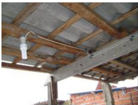
Figura 04: Instalações reformadas dispostas em roldanas
