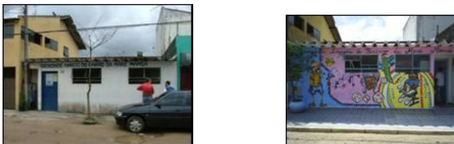
Figura 10: Creche da Comunidade Maré Mansa, antes e após a reforma
