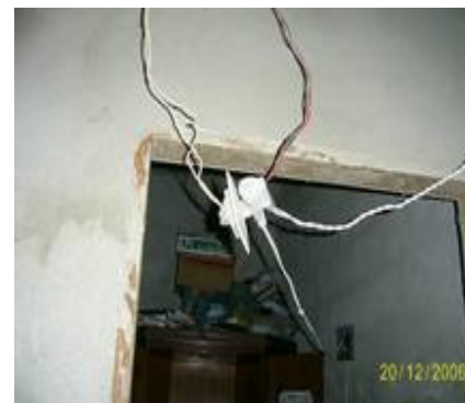
Figura 02: Situação em que mais de um equipamento está ligado na mesma tomada, que por sua vez está em condição insegura tanto para desligar equipamentos como com sobrecarga.
