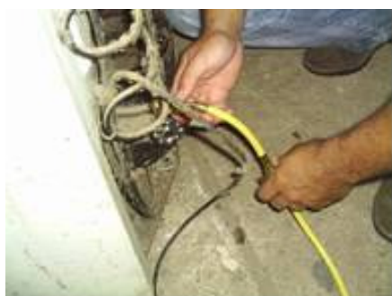
Figura 08: Processo de descaracterização e retirada do gás CFC dos refrigeradores substituídos.
