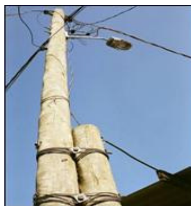
Figura 06: Na adequação da rede de distribuição e iluminação das vielas e becos foram instalados postes que, para serem levados aos pontos de engastamento, tiveram que ser seccionados e posteriormente “emendados”. Também foi necessária a redução do braço de iluminação para possibilitar a iluminação da passagem.
