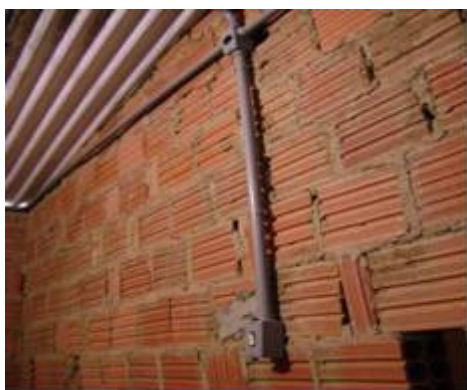
Figura 03: Instalações reformadas utilizando condulettes
