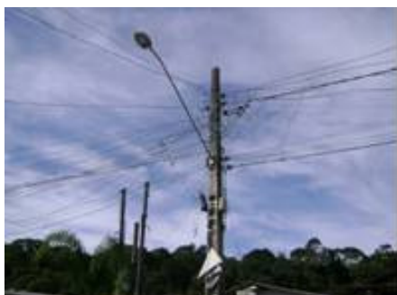
Figura 05: a) Poste contendo ramal clandestino que energizava uma das comunidades atendidas. b) Sistema de iluminação improvisado pelos moradores nas vielas e becos.
