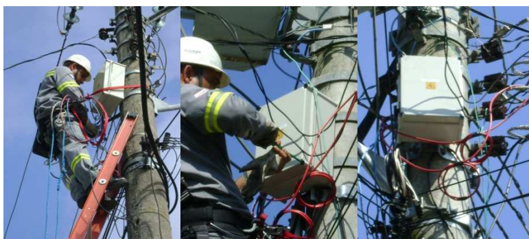
Figura 2: Instalação Sistema de Medição – Equipe EDP Bandeirante
