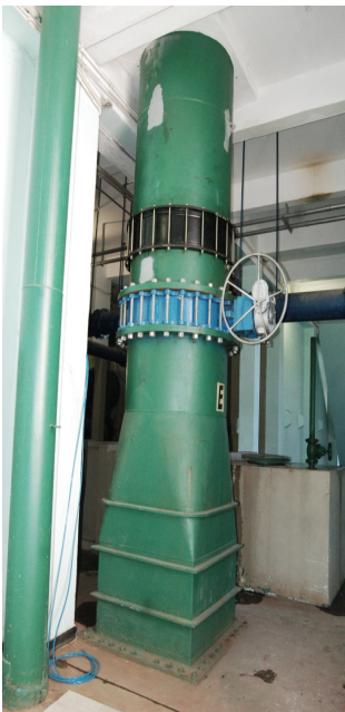
Figura 5 -Válvulas de Ø 1200mm
