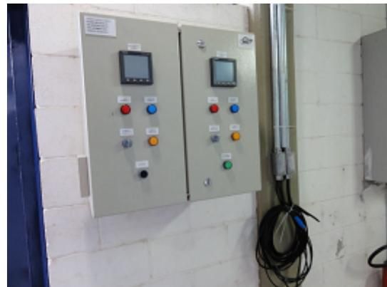
Figuras 09 e 10 – Painel com sistema de automação da Captação Mogi-Guaçu
