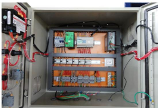
**Figuras 06 e 07 – Painel com sistema de automação da Captação Tamburuy**
