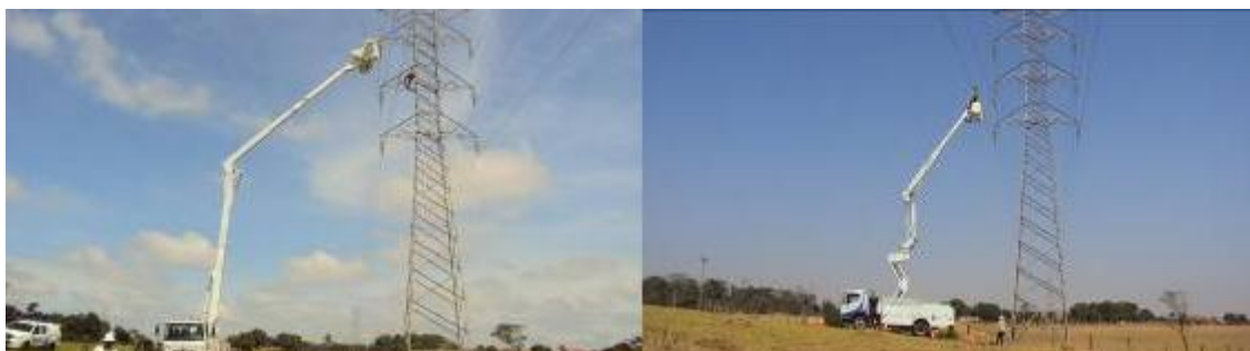
Foto 5 – Cesta aérea na substituição de isoladores de suspensão
