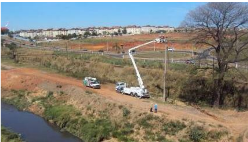
Foto 3 – Utilização da cesta aérea nas atividades de linha viva de 13, 8 kV
