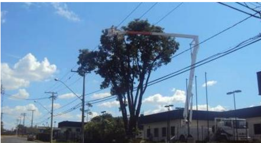
Foto 8 – Cesta aérea na realização de poda de árvores de grande porte – 13,8 kV
