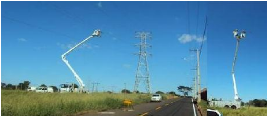
Foto 6 – Cesta aérea na confecção de reparos de cabos condutores em regime energizado
