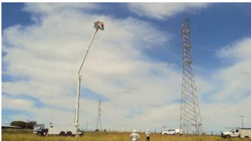
Foto 4 – Instalação de esferas de sinalização
