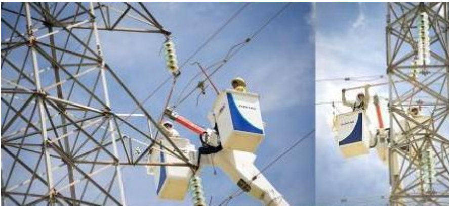
Foto 7 – Posicionamento durante a realização das atividades de substituição de isoladores
