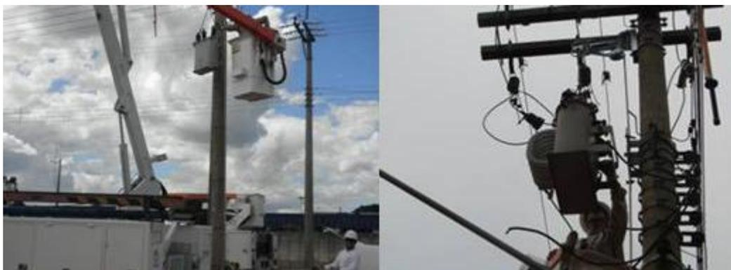
**Figura 7 – Substituição de transformadores utilizando guincho cabrestante e corda.**
