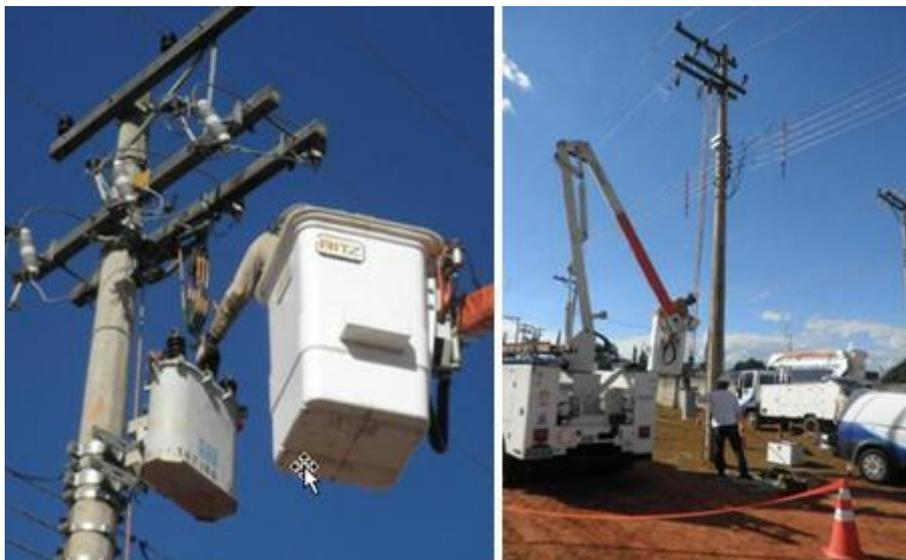
**Figura 8 – Substituição de transformadores utilizando guincho cabrestante e moitão.**
