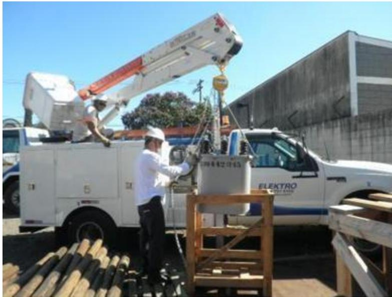
**Figura 2 – Utilização da talha de corrente para içamento dos transformadores.**
