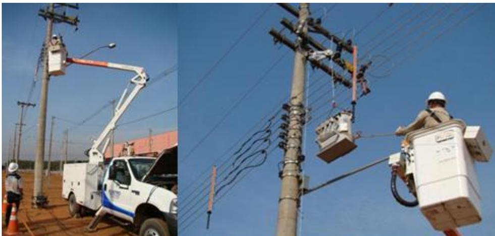
**Figura 6 – Substituição de transformadores utilizando guincho elétrico.**
