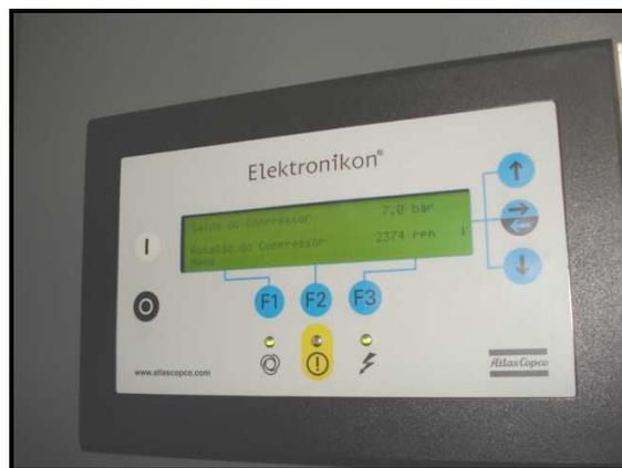
Fotos 03 e 04 – Compressor novo e sistema de controle incorporado.
