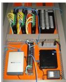
Figura 3. Quadro de comando do sistema de iluminação.
