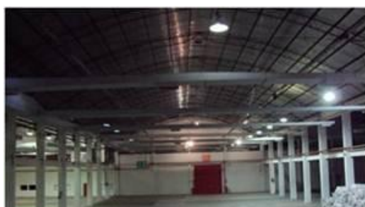
Figura 1. Ambiente 16 – Pavilhão B3. Substituição de luminária com lâmpada Vapor de Mercúrio de 250 W e Mista de 250 W por Vapor Metálico de 250 W.
