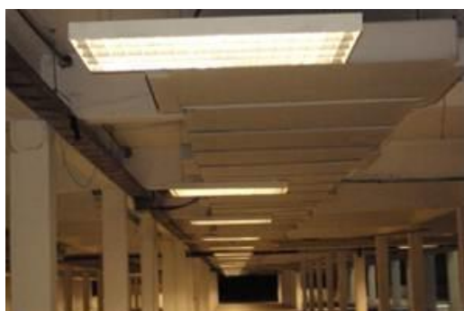
Figura 2. Ambiente 20 – Pavilhão C3. Substituição de luminária e lâmpada FT 1x110 W, luminária e lâmpada FT 2x40 W e Mista de 150 W por FT 4x32 W.
