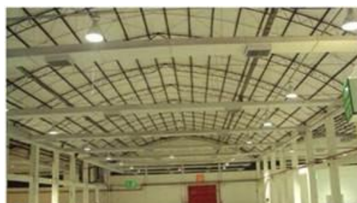
Figura 1. Ambiente 16 – Pavilhão B3. Substituição de luminária com lâmpada Vapor de Mercúrio de 250 W e Mista de 250 W por Vapor Metálico de 250 W.
