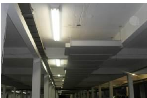
Figura 2. Ambiente 20 – Pavilhão C3. Substituição de luminária e lâmpada FT 1x110 W, luminária e lâmpada FT 2x40 W e Mista de 150 W por FT 4x32 W.
