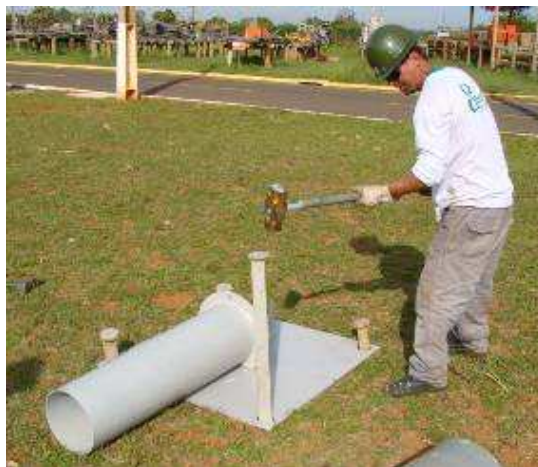
Foto 02: A base é fixada ao solo com quatro agulhas de 1 metro de comprimento.
