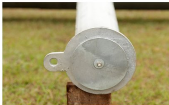
Detalhe da extremidade da mísula do para-raios
