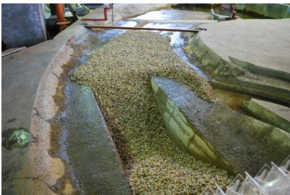
Figura 14 – Fossa de Erosão formada após ensaio com da Alternativa 7 com a vazão decamilenar.
