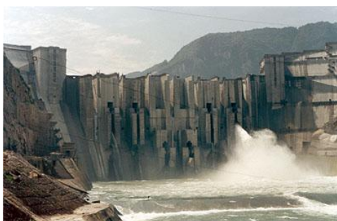
Figura 1 – Defletores em fenda sendo utilizados na barragem de Geheyan.
