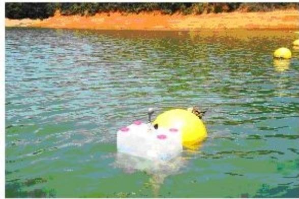
Figura 10. Sistema montado para extração de metano na região das bóias do vertedouro.
