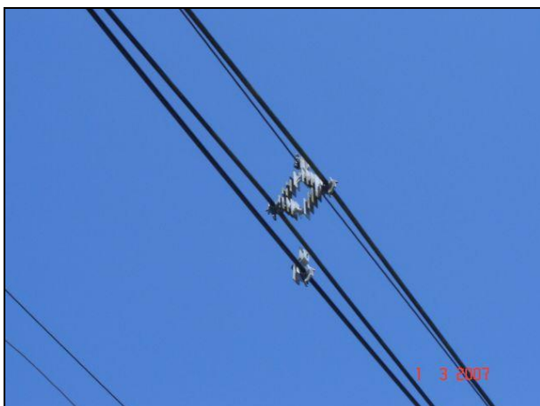
Figura 2: Isolador espaçador de PEAD
