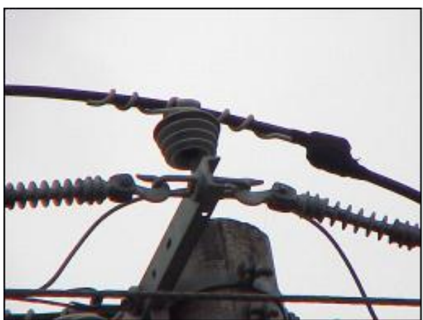
Figura 3: Isolador de sustentação tipo pino de PEAD
