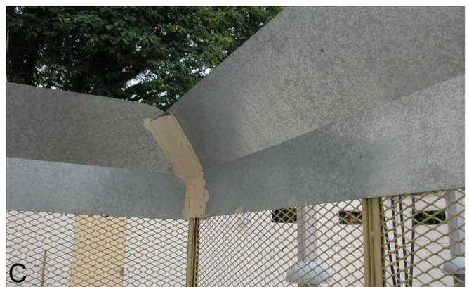
Figura 4 – 3A, 3B, 3C - Estrutura em chapa galvanizada como barreira de acesso ao *Didelphis*.
