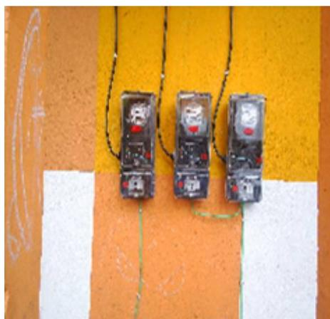
Figuras 5 e 6 : ligação do cabo concêntrico na caixa de derivação e nos medidores
