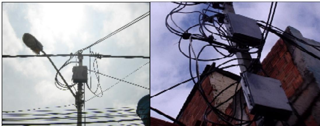
Figuras 3 e 4 : Instalação do cabo na caixa de derivação
