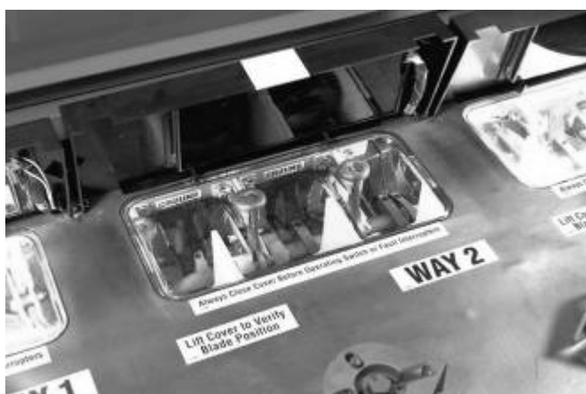
Imagem 3: Janela de Inspeção que Permite Visualização dos Contatos da Chave
