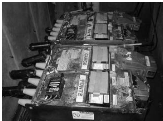
Imagem 2 – Diagrama unifilar da chave e Chave instalada em câmara subterrânea
