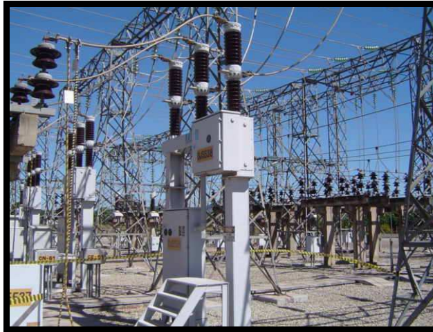
FIGURA 02 – Disjuntor de 72,5kV a SF6 com acionamento a mola.
