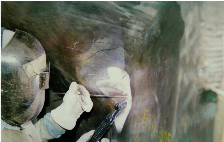
Figura 1 – Recuperação de trinca no rotor Francis da UHEGJR.
