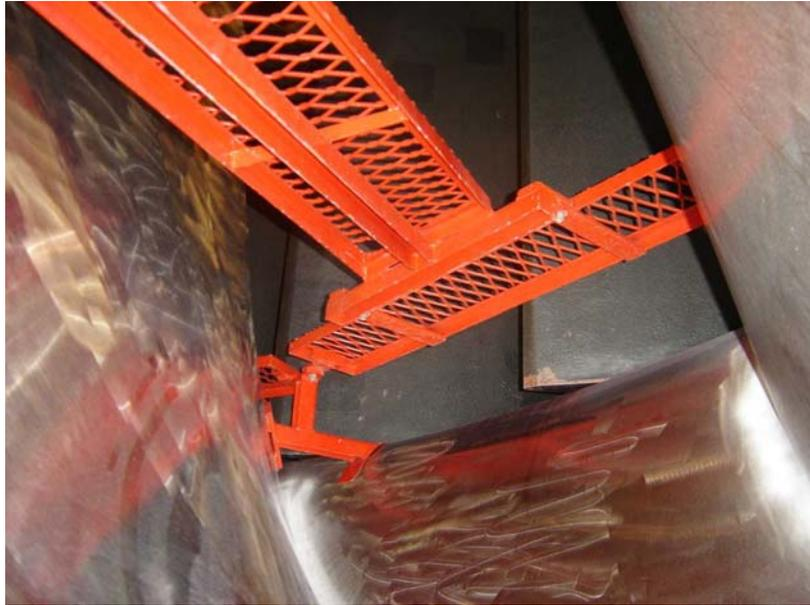
Figura 4 – Passarela de acesso as pás da turbina instalada na unidade.
