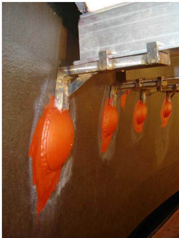
Figura 2 – Discos esféricos soldados ao tubo de sucção para apoio das vigas transversais.
