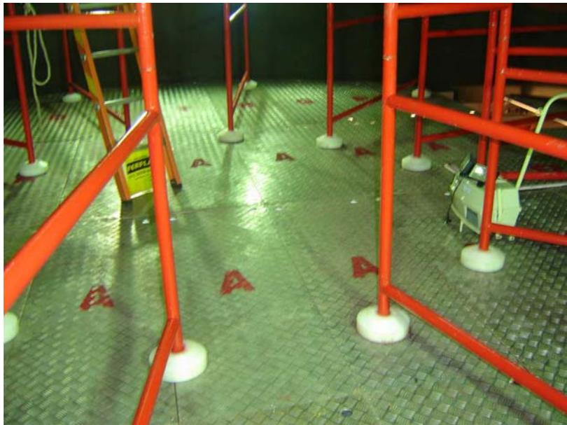
Figura 3 – Revestimento da plataforma e andaime em alumínio antiderrapante.
